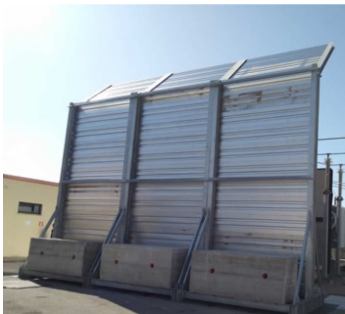
Figura 6.5.1. - Esempio di barriera acustica per cantierizzazione
