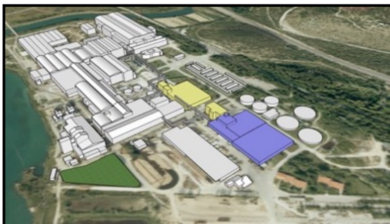
Figura 6.2.1.1_ Costruzioni e demolizioni.
